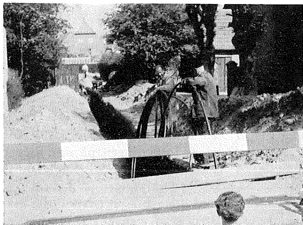
Fig. 6. Stikledning af Polyætylen. (Odense vandforsyning).
